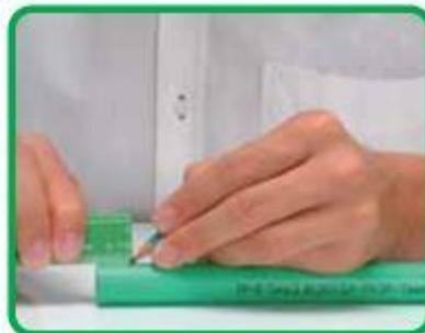
Marcar el extremo del tubo de acuerdo a las medidas de penetración.
