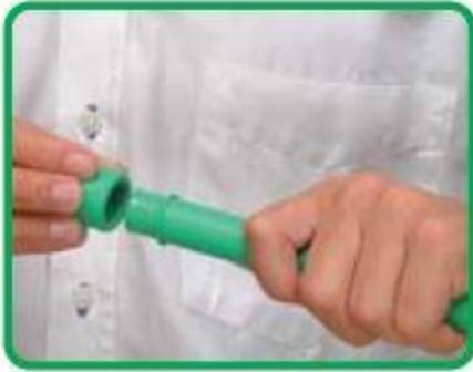
Después de retirar el tubo y la conexión del termofusor, procede **sin pausa** a unir los dos materiales, con tranquilidad, sin intervalos, hasta los topes.
