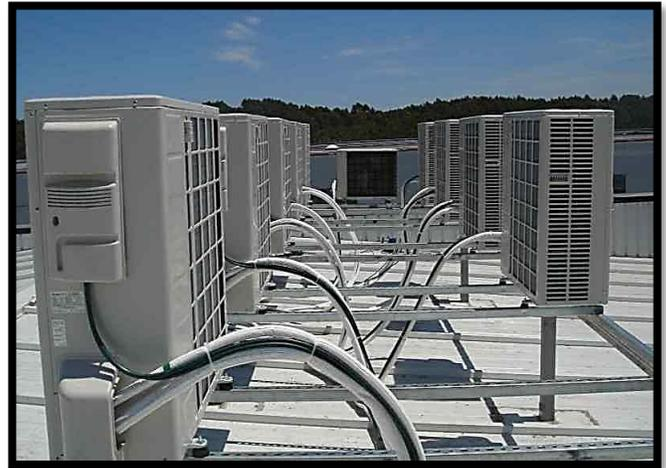
10. Conexión de tubería a unidad condensadora (Si la instalación requiere de mas de 5 metros de altura de la tubería ya suministrada colocar sifones cada 5 mts)
