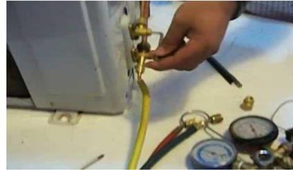
2.\_Realizar el vacío normal del equipo sin abrir la bolla de gas refrigerante, una vez terminado el vacío cerrar válvulas de juego de manómetros, voltear la bolla de gas refrigerante y pesarlo en la báscula.
