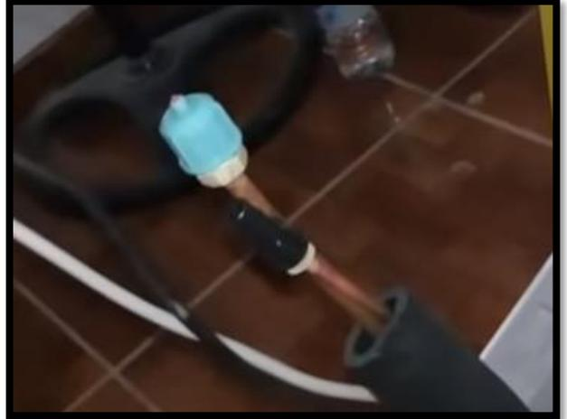
5. Encintado de tubería, aislado térmico.
