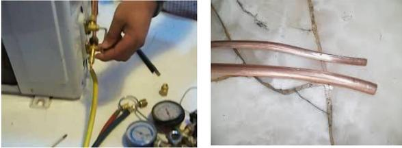
2.\_Soldar una válvula de prueba al tubo más delgado (alta).
