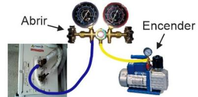
2. Se procede al encendido de la bomba de vacío e inmediatamente se abre la válvula de baja del juego de manómetros,
