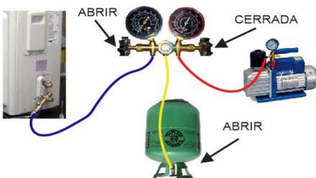
6.\_Una vez alcanzada los gramos de refrigerante checar el amperaje del compresor, después dejar que el equipo trabaje hasta alcanzar la temperatura programada.
